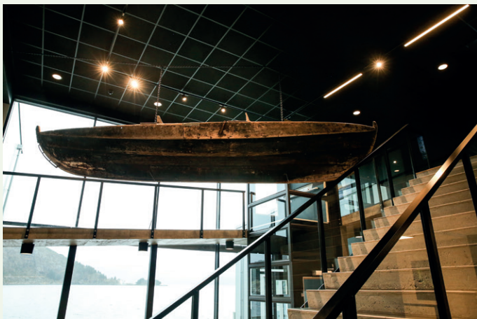
Fra inngangspartiet der vi ser trappa med gjenbrukt betong, en dekorativ gammel trebåt i taket som symboliserer verdiene Måløysamfunnet er bygget på, glassfasade fra H-Fasader og systemhimling i taket.
