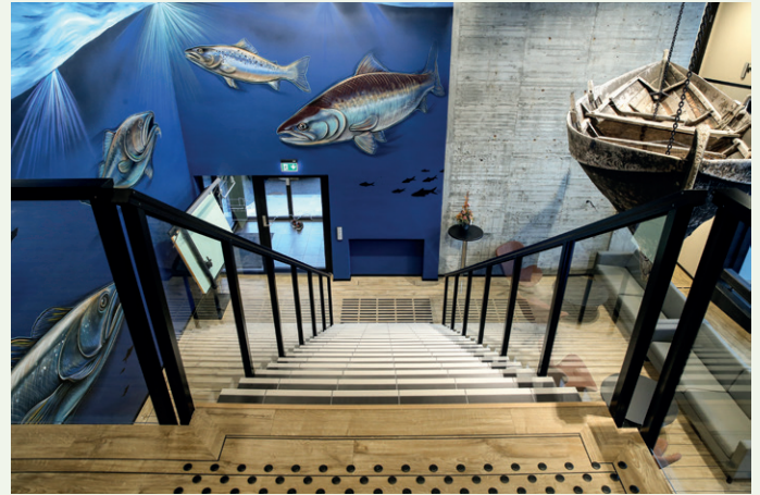
Det karakteristiske inngangspartiet gjør at du umiddelbart skjønner at du befinner deg i et maritimt miljø. Trappa er gjenbrukt fra den gamle yrkesskolen. Gulvene har skipsgulv. Den eksponerte betongveggen bak viser eksempel på gjenbruk av betong fra bygget var nytt i 1958.
