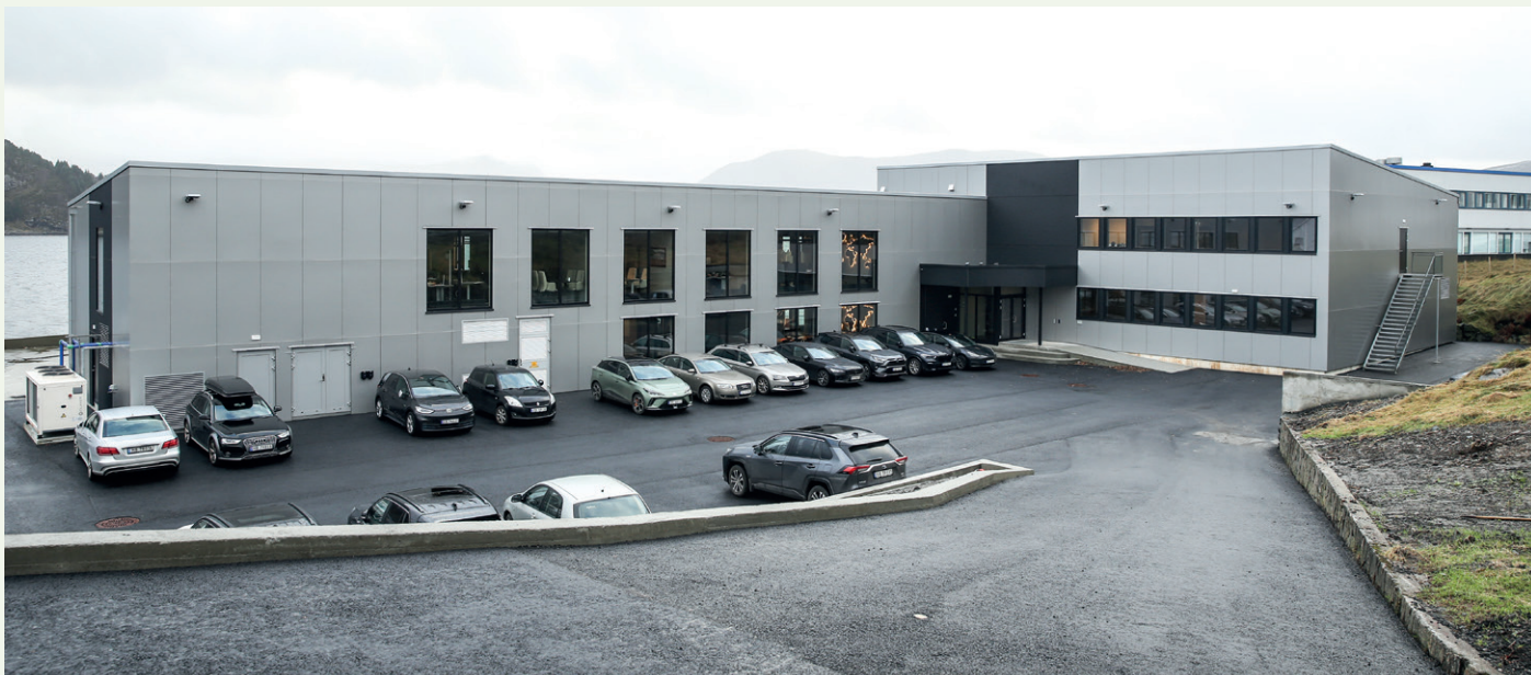
Bygget sett fra inngangspartiet med innkjøring og parkeringsplass mot nordvest. Fasaden med tosidig aluminiumsbelagte plater med kompositt er levert av Ytre Fasade i Haugesund. H-Fasader har levert fasade, vinduer og ytterdører til prosjektet.
